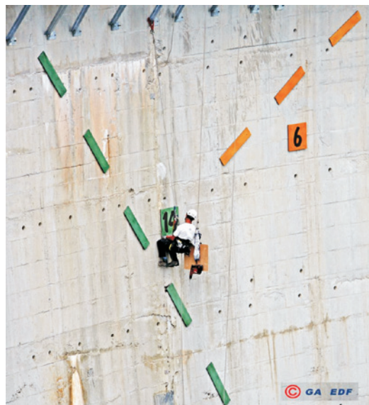
Abb. 11: Stundenmarkierung an der Staumauer. © Savoie/EDF
