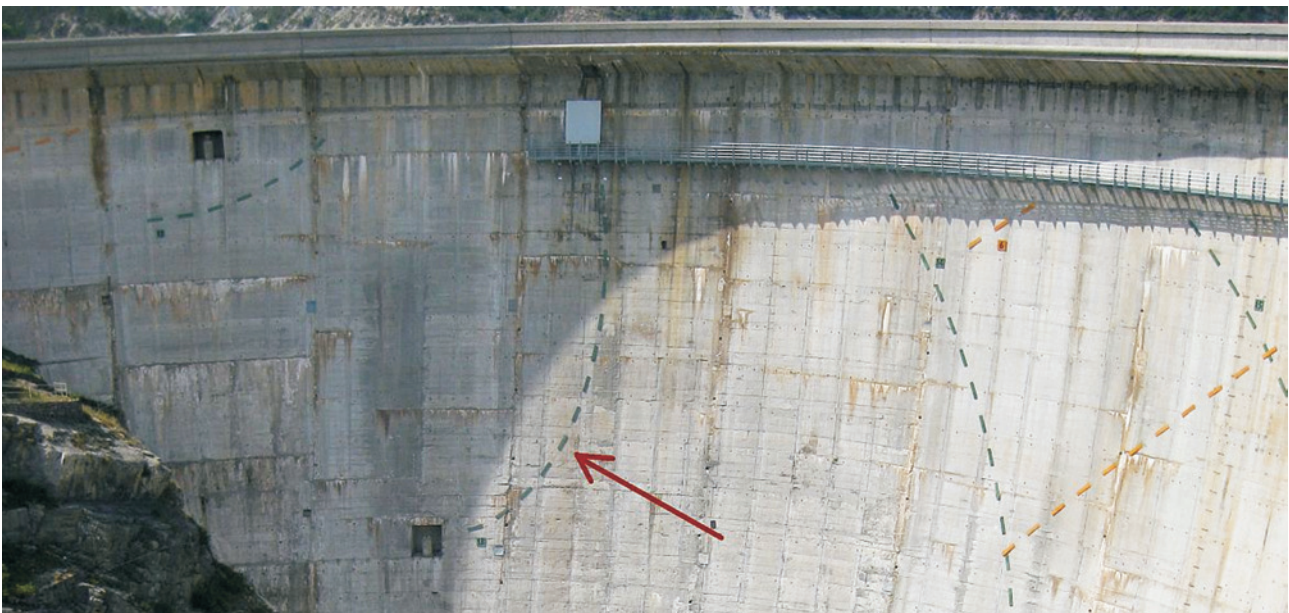
Abb. 14: Die Sonnenuhr auf der Staumauer zeigt kurz vor 13 Uhr. © Savoie/EDF
